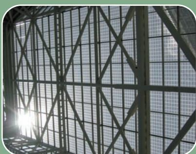
El primer edificio que aplicó el concepto de fotovoltaica integrada en edificios fue la biblioteca de Mataró (en Barcelona), donde toda la fachada frontal consta de doble acristalamiento con células fotovoltaicas integradas en el cristal exterior y 4 lucernarios fotovoltaicos (en total tiene 53  $kW_p$  instalados).
