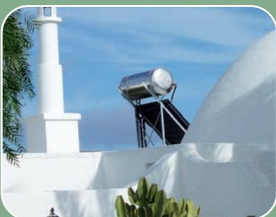
Entre los colectores y el acumulador circulan de 10 a 40 litros de agua/hora y por  $m^2$  de superficie de colector plano.
