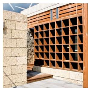
Es un elemento exterior o interior compuesto por láminas situadas en la totalidad de una ventana. Las láminas pueden ser fijas o móviles; cuando son móviles se pueden ajustar según el ángulo del Sol.
