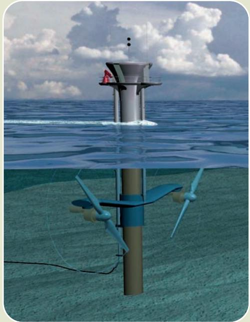
El SeaGen es un generador de 1,2 MW que utiliza las corrientes marinas (de la empresa Marine Current Turbines). Está instalado en la costa de Irlanda del Norte y será capaz de producir electricidad para 1000 hogares.
