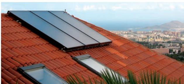
Colector solar integrado en techo
