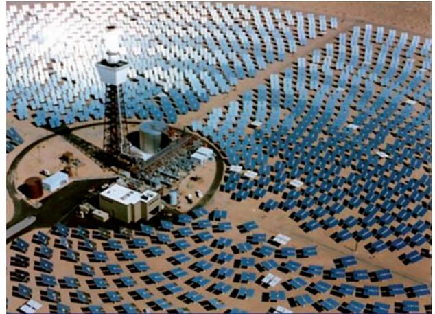
Sistema solar con torre y heliostato
