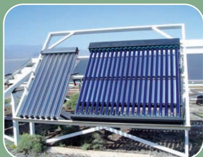
En el sur de Europa, para suministrar agua caliente sanitaria (ACS) a una vivienda unifamiliar se suele utilizar un sistema de termosifón, con un colector de unos 2 a 5 m<sup>2</sup> y un depósito de 100 a 200 litros. Por contra, en el centro y norte de Europa se suelen instalar sistemas de circulación forzada, con un colector de 3 a 6 m<sup>2</sup> y un acumulador de 150 a 400 litros.
