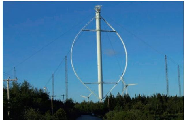
Aerogenerador de eje vertical tipo Darrieus
